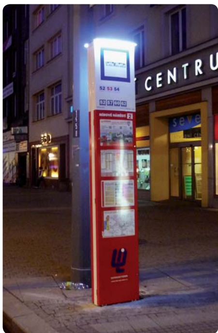
Pro osvětlení je ve stříšce označníku umístěna LED páska.
