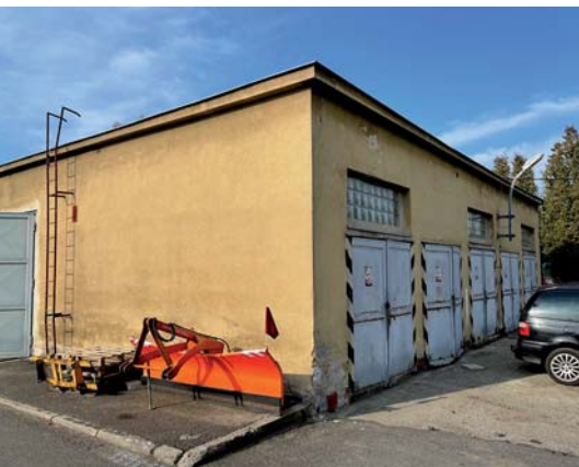
Budova pomocných provozů v areálu Předlice před zateplením
