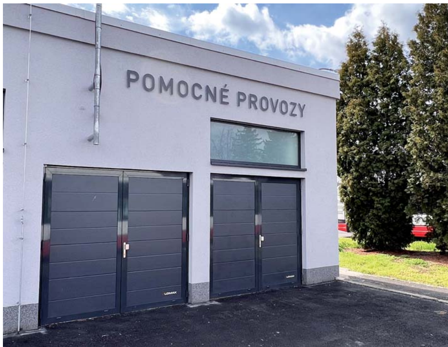
Budova pomocných provozů v areálu Předlice po realizaci dotačního projektu
