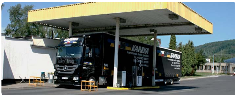
Čerpací stanice provozuje Dopravní podnik v areálu předlické autobusové vozovny
